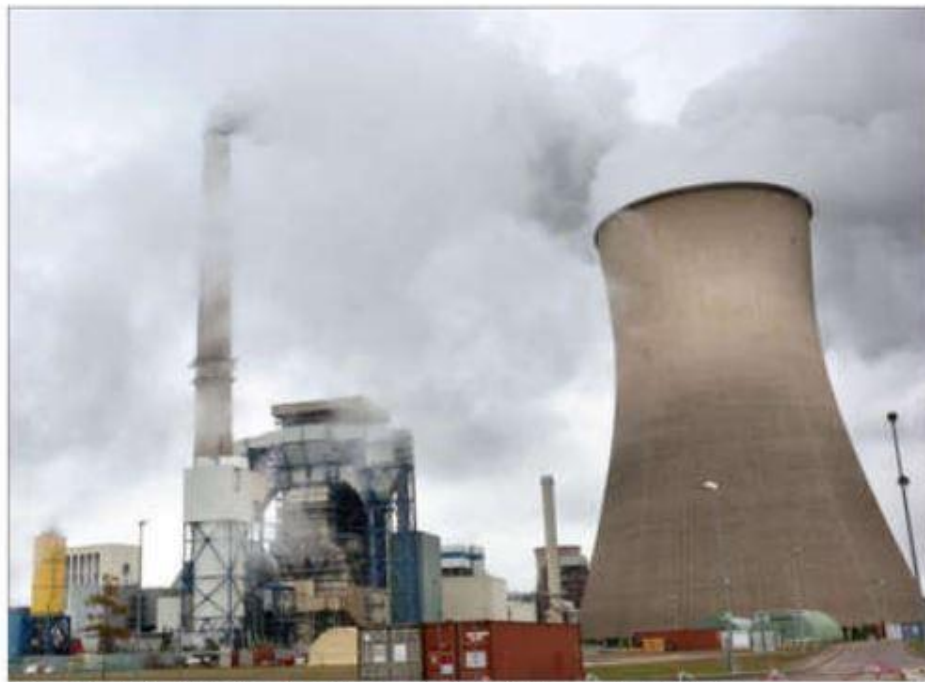
La centrale Emile-Huchet à Saint-Avold est désormais pilotée par Gazel Energie.
